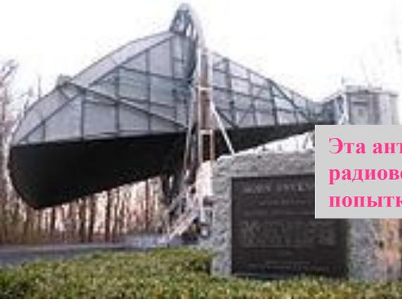
Эта антенна предназначалась для регистрации радиоволн, отраженных от сферических спутников – попытка создания дальней радиосвязи...
